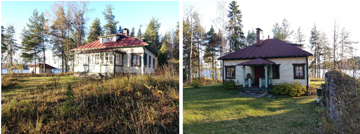
Kuvat 129 ja 130. Vasemmalla päärakennus ja saunarakennus. Oikealla päärakennuksen pihan puoleinen julkisivu.
