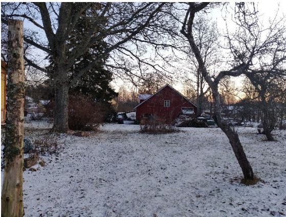
Kuva 41. Entinen navettarakennus pihapiirin reunassa, välissä omenapuita.
