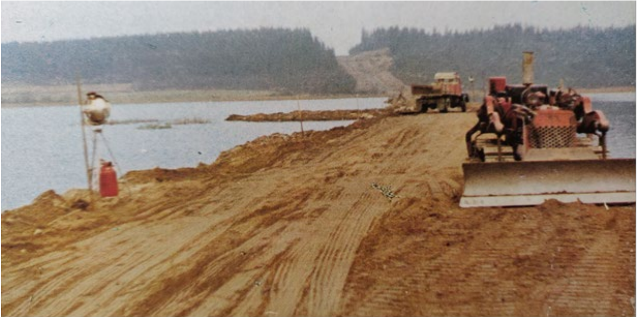
Kuva 6. Pengertien rakennustöitä. Kuvan lähde: Taipalsaari, pitäjä Saimaan sylissä.
