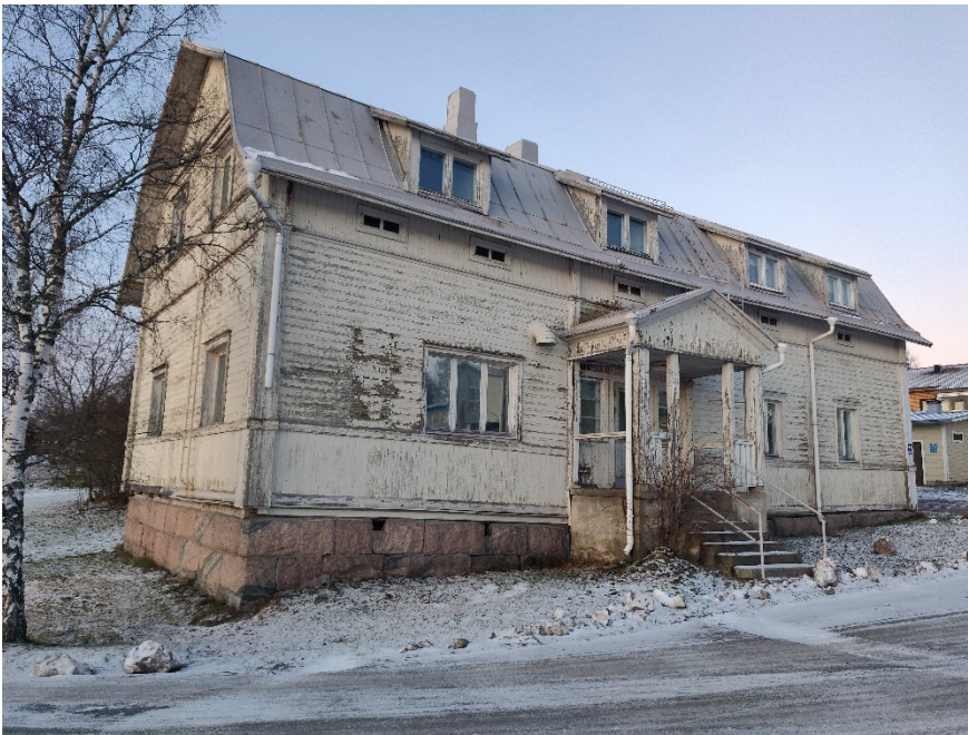
Kuva 22. Vanhan kunnantalon Kirkonrannantien puoleinen julkisivu.
