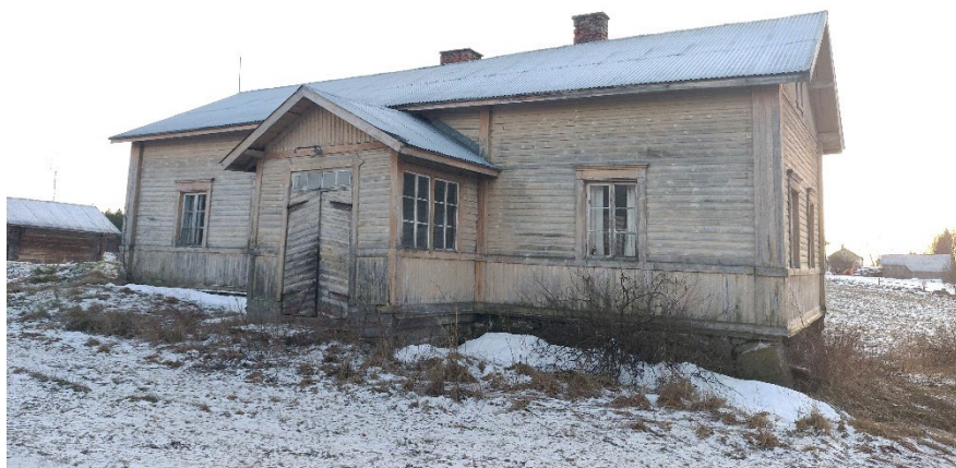
Kuva 71. Rantatalo kuvattuna pihan puolelta.
