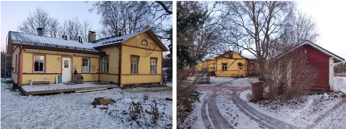
Kuvat 39 ja 40. Vasemmalla päärakennuksen luoteisjulkisivu. Myöhemmin rakennetun laajennuksen yhteyteen on tehty terassi. Ovia ja ikkunoita on uusittu. Oikealla päärakennus ja aitta Muukkolantieltä kuvattuna.
