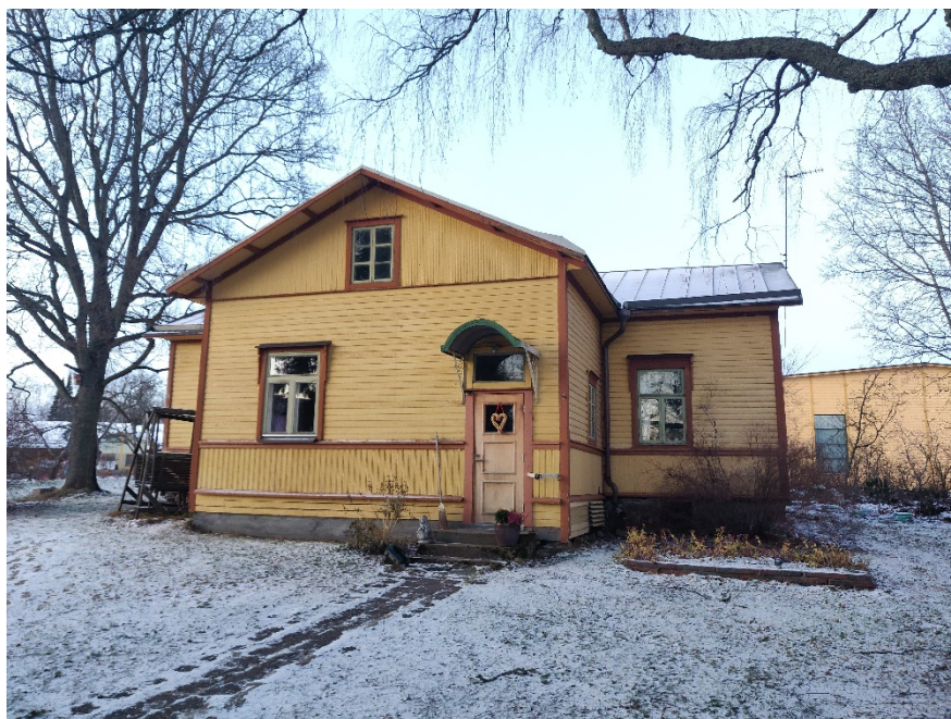
Kuva 38. Päärakennuksen kaakkoisjulkisivu. Perustuksen harmaakivet on peitetty betonilla. Ikkunoita on uusittu.
