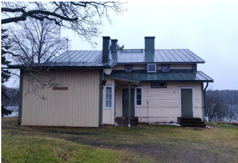
Kuva 19. Päärakennus, aiemmin nimismiehen virka-asuntona toiminut rakennus. Etualalla myöhemmin rakennettu siipi.
