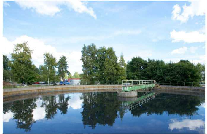
Kuva Toikansuon jätevedenpuhdistamo, Lappeenrannan Energia Oy
