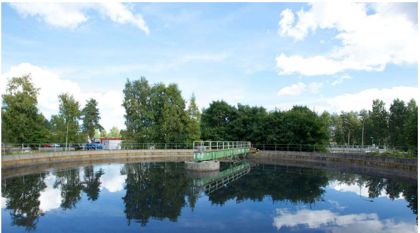
Kuva 10. Toikansuon jätevedenpuhdistamo, Lappeenrannan Energia Oy
