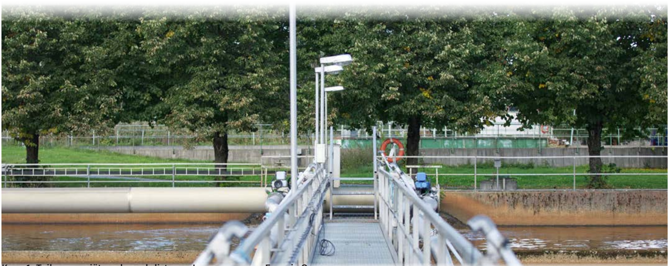
Kuva 1. Toikansuon jätevedenpuhdistamo, Lappeenrannan Energia Oy
